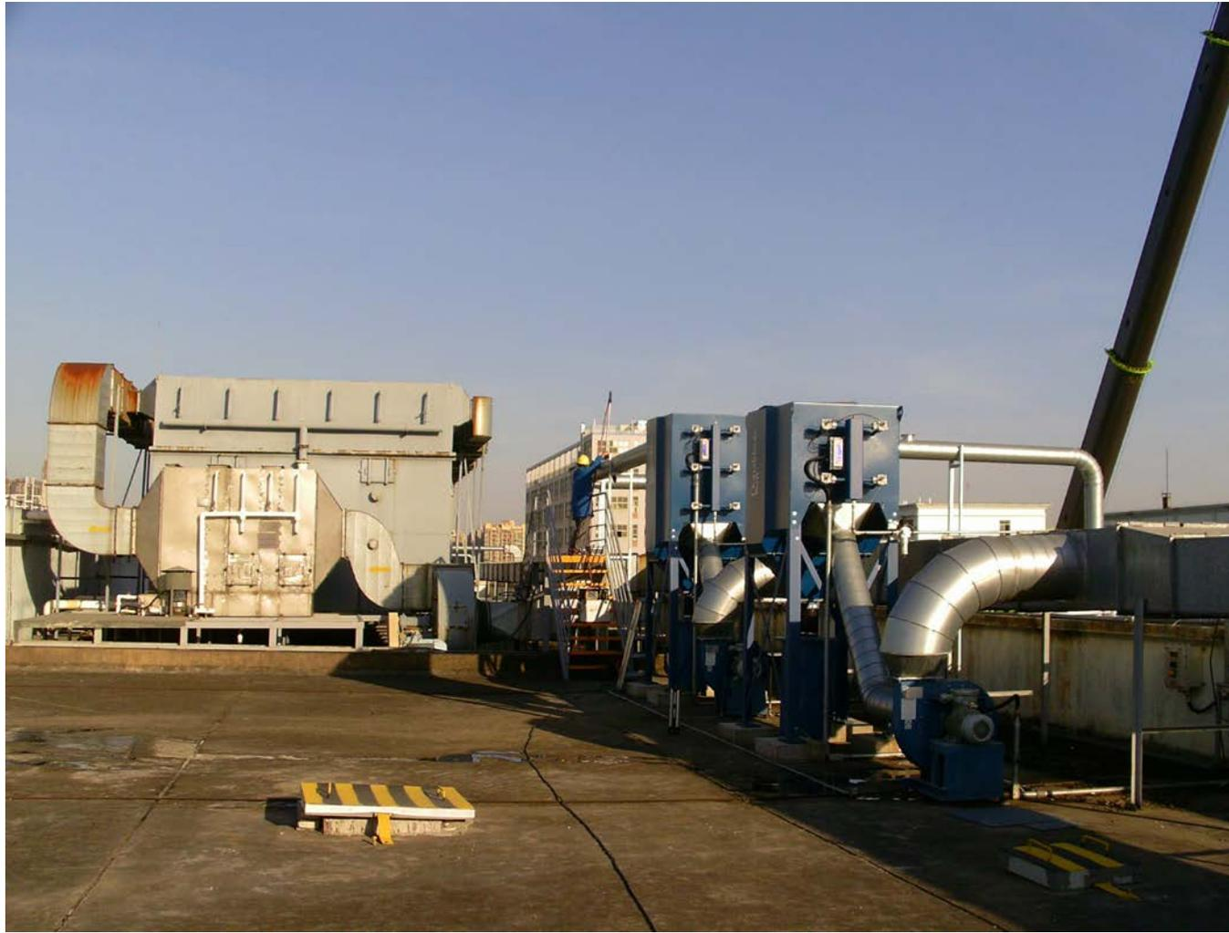
图 5-2 项目废气处理设施照片
